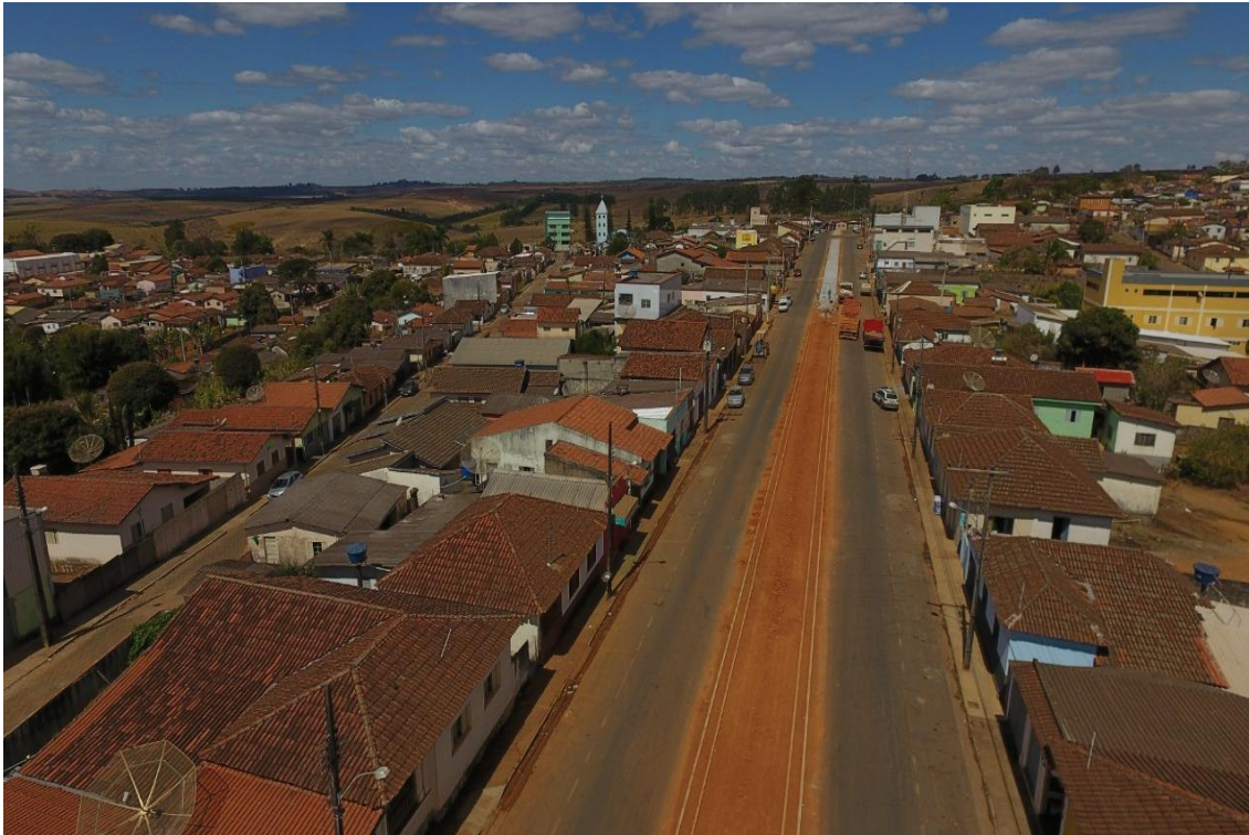
Avenida Antônio Machado Borges em obras. Foto: Arquivo Prefeitura Agosto/2020.
