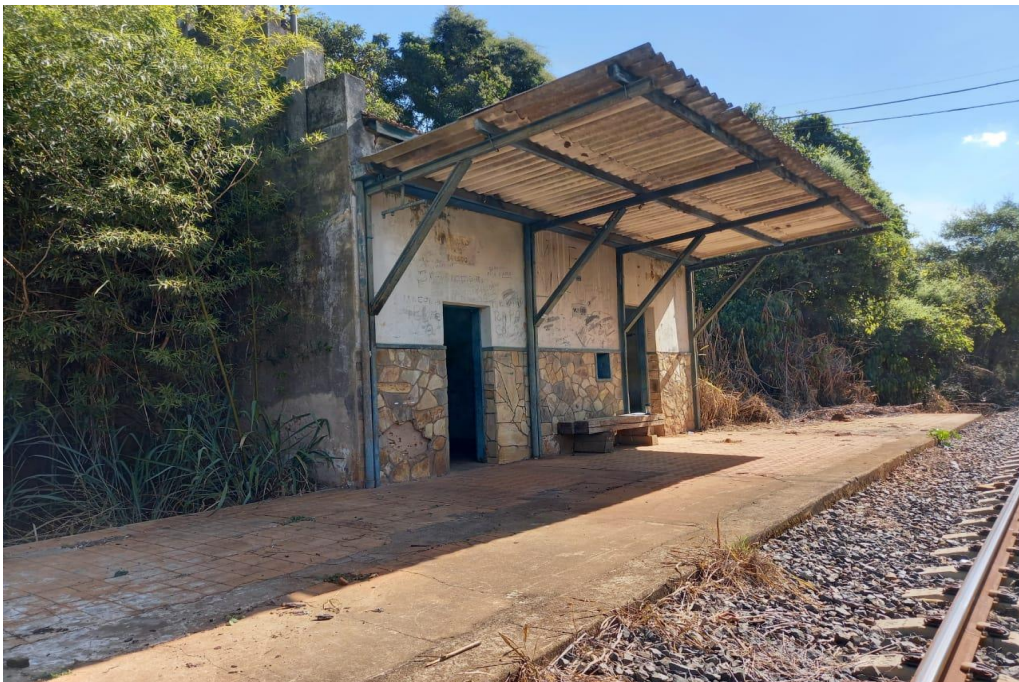
Fachada principal. Foto: Cristiano Eustáquio Valeriano, junho de 2021
