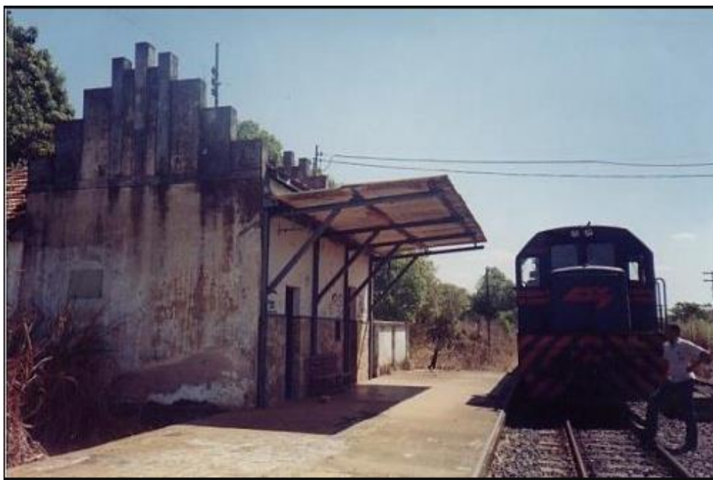
A estação de Pratinha com a locomotiva 2543 da FCA, em 2003. À sua frente, o maquinista. Foto Décio Marques | Foto: Estações Ferroviárias
