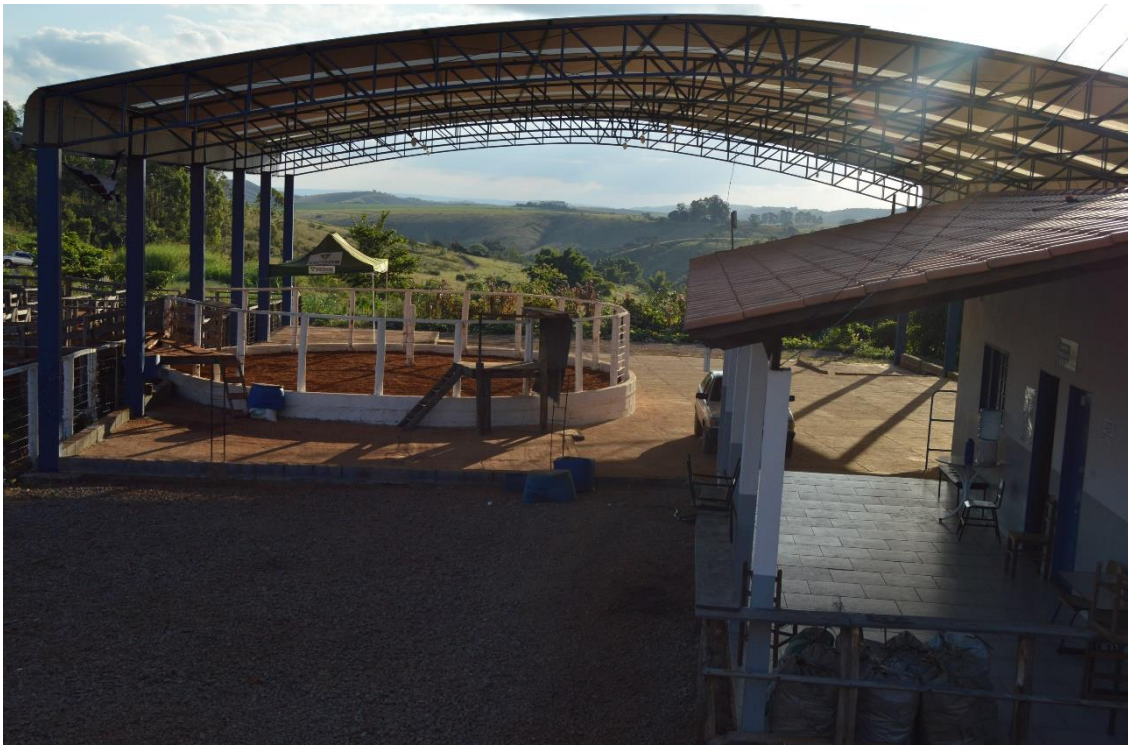
Galpão, parte do curral e da área para leilões de gado, e estrutura de apoio. Foto: Cristiano Eustáquio Valeriano, junho/2018.
