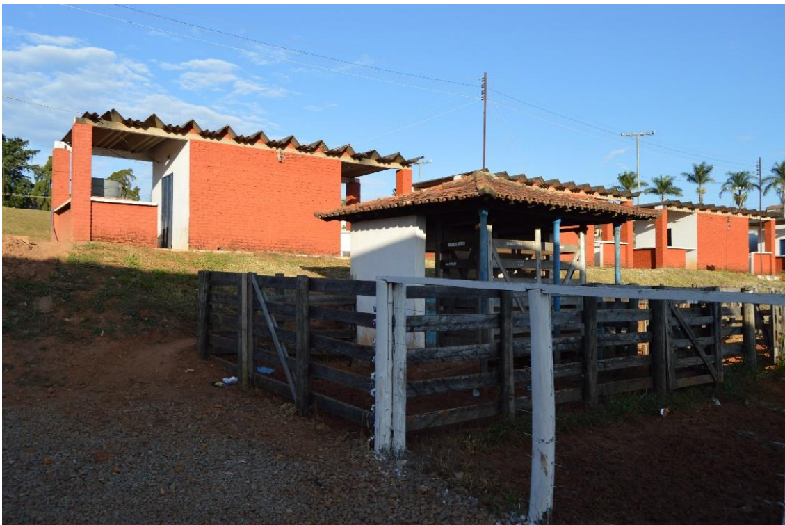
Estruturas de apoio. Foto: Cristiano Eustáquio Valeriano, junho/2018.
