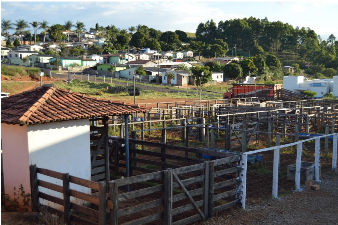
Curral e a ocupação do entorno: verifica-se a tendência ao adensamento com a ampliação das áreas construídas dos lotes. Foto: Cristiano Eustáquio Valeriano, junho/2018.
